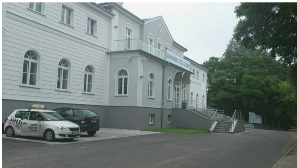
Zdjęcie 2. PKP Dworzec Kolejowy w Gryfinie
