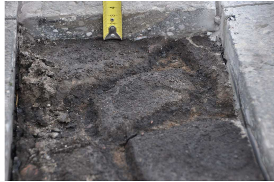
Fot. 7: Wycinek nawierzchni jezdni na odcinku nr 3 (strona prawa).
