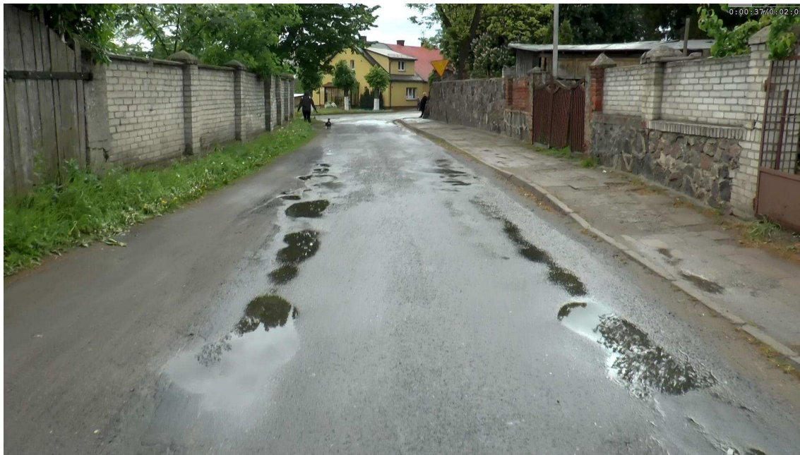
Fot. 1: Istniejący stan jezdni na odcinku od km 0+000 do km 0+086
