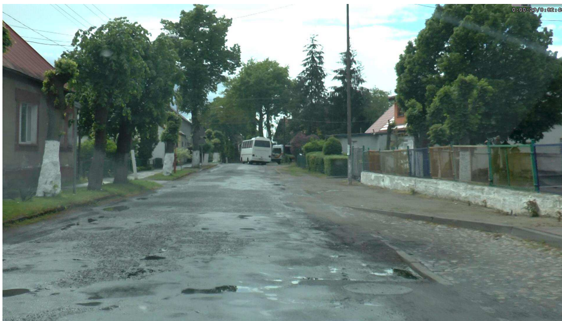
Fot. 2: Istniejący stan jezdni na odcinku od km 0+0,086 do końca opracowania
