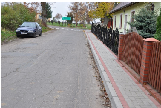
Fot. 8: Istniejący stan nawierzchni na odcinku nr 4.
