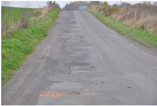
Fot. 6 Istniejący stan nawierzchni na odcinku nr 4.
