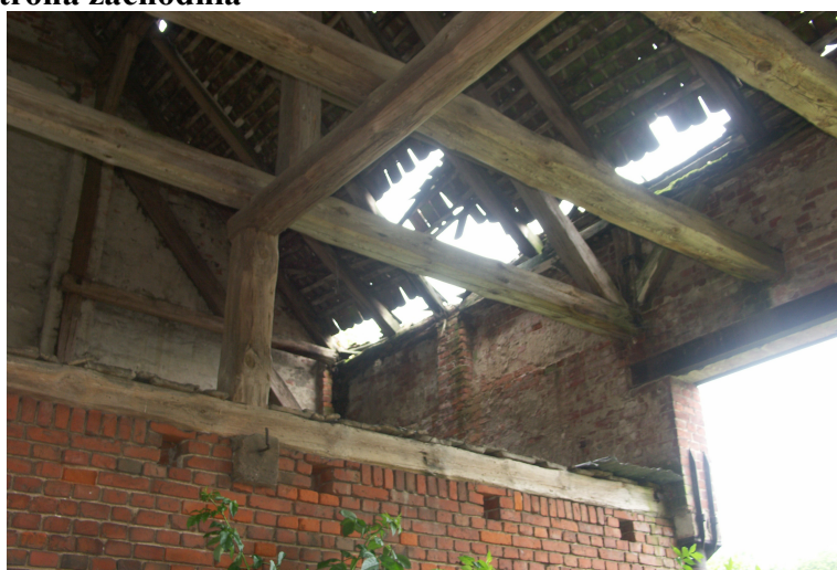
zdj. 30 Widok konstrukcji dachu oraz przekrycia od strony wewnętrznej prześwitu bramnego oraz nad przeszłem 11 strona zachodnia, uwidoczniono zniczenie pokrycia dachowego oraz erozję cegieł muru ściany zewnętrznej
