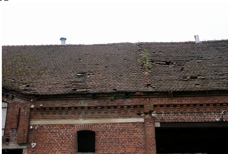
zdj. nr 11 Widok górnego fragmentu (3 przęsła 7-9) elewacji zachodniej z uszkodzeniami dachu i muru
