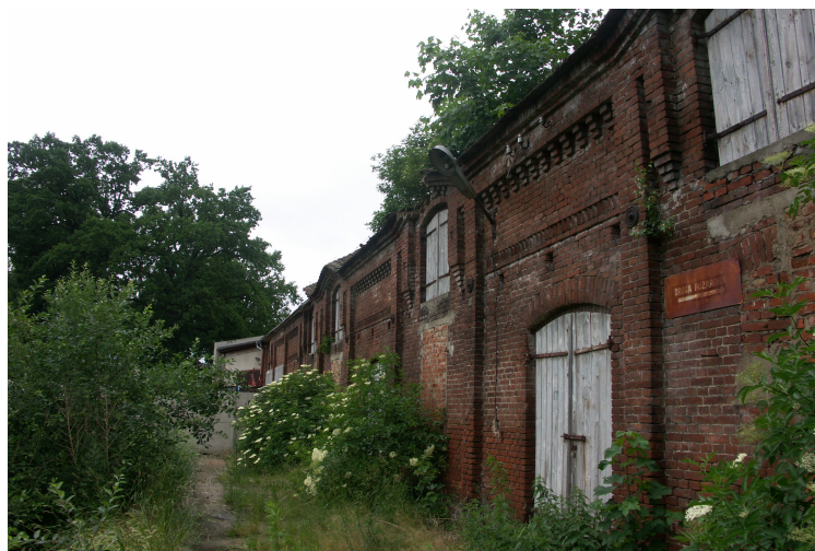
zdj. 14 Widok fragmentu (6 przęseł 1-6) elewacji zachodniej z uwidocznionymi uszkodzeniami muru oraz zmianami w elewacji budynku – zamurowaniami otworów
