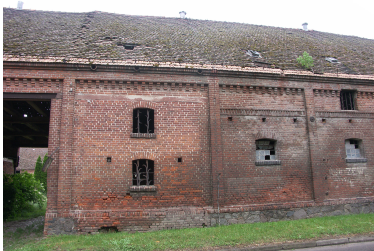
zdj. 4 Widok fragmentu (3 przęsła od 7-9) oraz fragment prześwitu bramnego elewacji wschodniej budynku gospodarczego, z widocznymi ugięciami dachu, liczne ubytki w spoinach cegieł oraz ubytki „sypiących się” cegieł również w przemurowanym fragmencie cokółu (w pozostałych przęsłach cokół kamienny)
