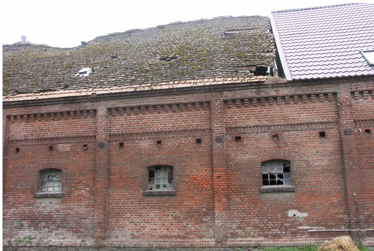
zdj. nr 1 Widok fragmentu (3 przeszła) elewacji wschodniej budynku gospodarczego oraz zabudowy przyległej (poza zakresem opracowania – działka 139/1), uwidoczniony zły stan dachu – liczne ugięcia konstrukcji oraz ubytki dachówki ceramicznej karpiówki, liczne ubytki w spoinach cegieł oraz ubytki „sypiących się” cegieł (erozja na skutek zawilgocenia)
