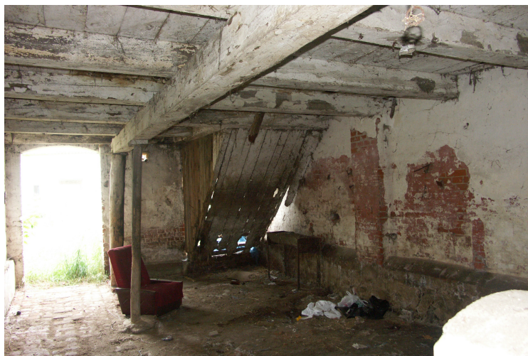
zdj. 28 Widok wnętrza poziomu dolnego (I kondygnacja) przeszło 9 strona zachodnia z uwidocznionymi uszkodzeniami stropu belek stropowych - ugięcia oraz muru wewnętrznego
