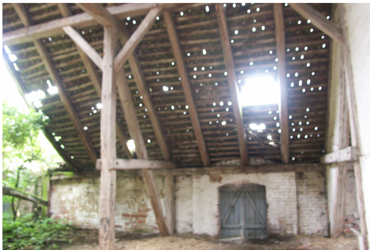
zdj. 18 Widok wnętrza poziomu górnego (II kondygnacja) przęsła 1-3 strona zachodnia z uwidocznionymi uszkodzeniami dachu jak również stropu (erozja przez roślinność) oraz uszkodzeniami muru ( 1 przęsło)
