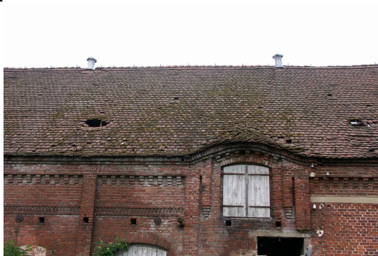
zdj. nr 10 Widok fragmentu (3 przęsła 5-7) elewacji zachodniej z uszkodzeniami dachu i muru
