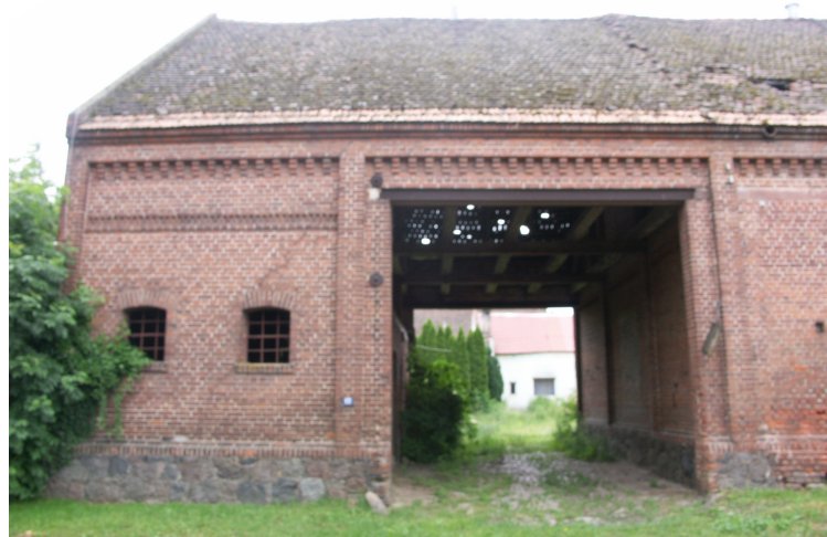
zdj. nr 5 Widok fragmentu (2 przęsła 10tj. prześwit bramny -11) elewacji wschodniej budynku gospodarczego, z widocznymi ugięciami dachu jak również pęknięciem muru w przęśle 11 biegnącym od cokółu kamiennego do otworu okiennego oraz od nadproża okiennego do pilastra ściennego poprzez gzyms pośredni na wysokości stropu wraz z wybrzuszeniem ściany
