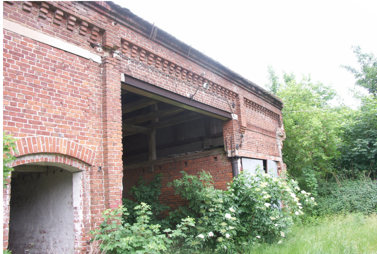
zdj. 16 Widok fragmentu (3 przęsła 9-11) elewacji zachodniej z uwidocznionymi uszkodzeniami muru (przerwana ciągłość oraz uszkodzenia cegieł pilastra jak również wymiana pilastra na słup stalowy w narożniku prześwitu bramnego, liczne ubytki spoiny oraz erozja na skutek zawilgocenia, "syjące się" cegły w strefie ściany wewnętrznej prześwitu bramnego
