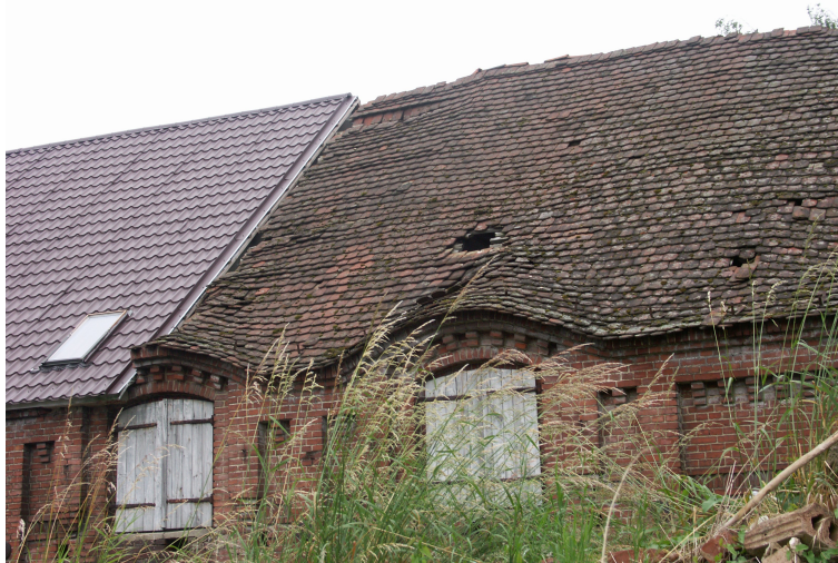
zdj. nr 7 Widok górnego fragmentu (3 przęsła) elewacji zachodniej budynku gospodarczego oraz zabudowy przyległej (poza zakresem opracowania – działka 139/1), uwidoczniony zły stan dachu – liczne ugięcia konstrukcji oraz ubytki dachówki
