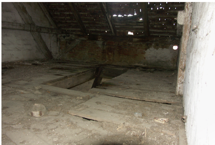
zdj. 24 Widok wnętrza poziomu górnego (II kondygnacja) przęsło 6 strona wschodnia z uwidocznionymi uszkodzeniami stropu oraz muru (zawilgocenie oraz uszkodzenia-zmiażdżenie cegieł uwidocznione poprzez ugięcie murlaty)
