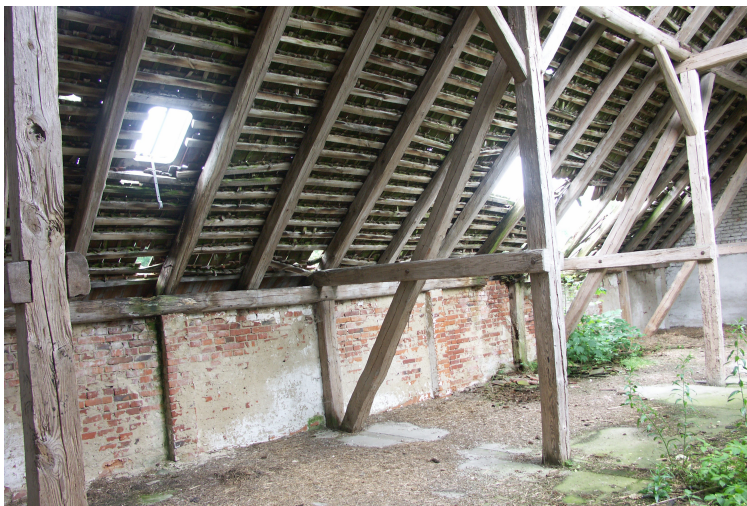
zdj. 19 Widok wnętrza poziomu górnego (II kondygnacja) przęsła 1-3 strona wschodnia z uwidocznionymi uszkodzeniami porycia dachu jak również stropu (erozja przez roślinność) oraz uszkodzeniami konstrukcji dachu - słupy
