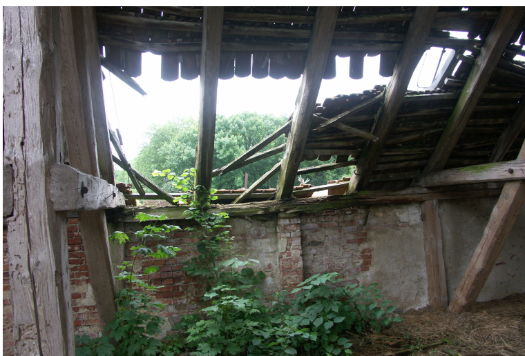
zdj. 21 Widok wnętrza poziomu górnego (II kondygnacja) przęsła 4-5 strona wschodnia z uwidocznionymi zniszczeniami konstrukcji dachu jak również stropu (erozja przez roślinność) oraz uszkodzeniami muru
