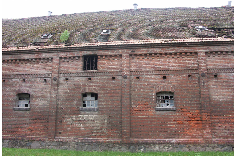
zdj. nr 3 Widok fragmentu (3 przeszła od 6-8) elewacji wschodniej budynku gospodarczego, z widocznymi ugięciami dachu, liczne ubytki w spoinach cegieł oraz ubytki „sypiących się” cegieł (erozja na skutek zawilgocenia)
