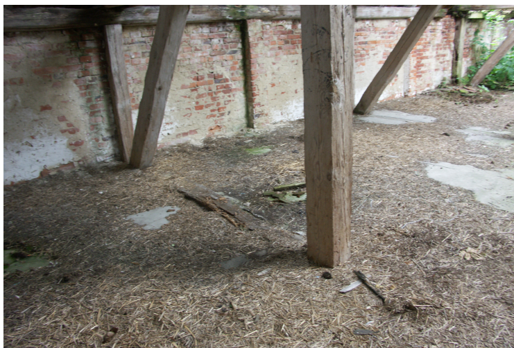
zdj. 20 Widok wnętrza poziomu górnego (II kondygnacja) przęsła 2 strona wschodnia z uwidocznionym szczegółem uszkodzenia podwaliny i belki stropowej jak również uszkodzeniami cegieł w strefie murlaty
