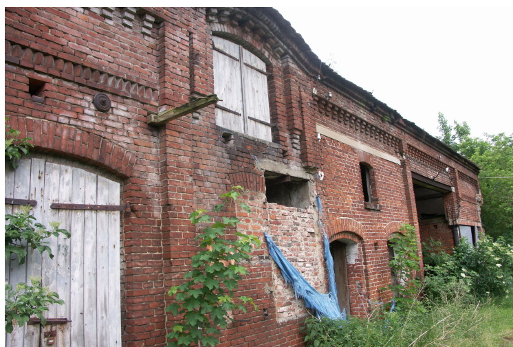
zdj. 15 Widok fragmentu (5 przęseł 7-11) elewacji zachodniej z uwidocznionymi uszkodzeniami muru, cegieł i spoin oraz zmianami w elewacji budynku – zamurowaniami otworów
