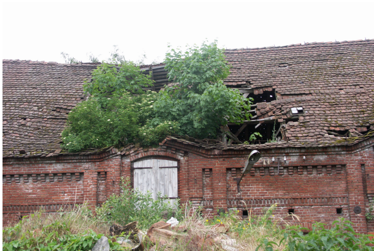
zdj. nr 9 Widok górnego fragmentu (3 przęsła 3-5) elewacji zachodniej budynku, uwidocznione zawalenie konstrukcji dachu, ubytki w gzymsach oraz nadprożu otworu, jak również erozja cegły z licznymi ubytkami spoiny (erozja na skutek zawilgocenia, "sypiące się" cegły) w strefie pod gzymsem górnym przęsła 5
