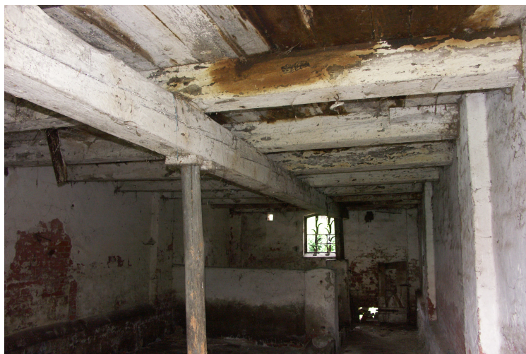
zdj. 26 Widok wnętrza poziomu dolnego (I kondygnacja) przeszło 9 strona wschodnia z uwidocznionymi uszkodzeniami stropu oraz muru (na „wylot”) ściany zewnętrznej
