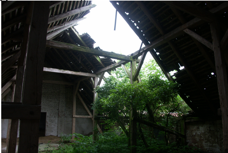
zdj. 17 Widok wnętrza poziomu górnego (II kondygnacja) przęsła 3-5 strona zachodnia z uwidocznionym zniszczeniem konstrukcji dachu jak również stropu (erozja przez roślinność)
