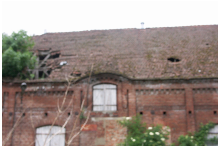
zdj. nr 10 Widok fragmentu (3 przęsła 5-7) elewacji zachodniej z uszkodzeniami dachu i muru
