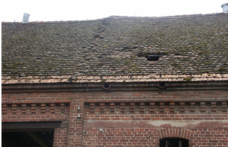
zdj. nr 6 Widok szczegółowy uszkodzenia dachu
