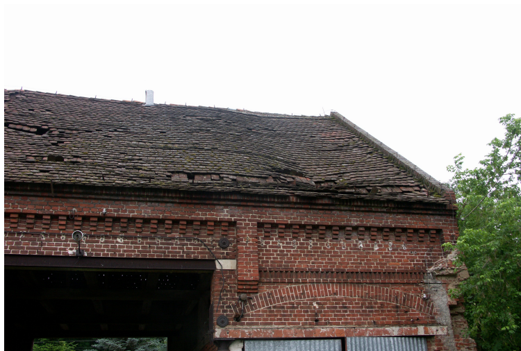
zdj. 13 Widok górnego fragmentu (2 przęsła 10 tj.prześwit bramny-11) elewacji zachodniej z uszkodzeniami dachu oraz uwidocznionymi zmianami w elewacji budynku
