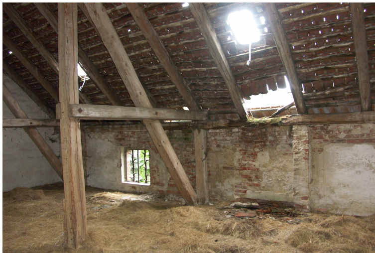
zdj. 22 Widok wnętrza poziomu górnego (II kondygnacja) przęsła 7-8 strona wschodnia z uwidocznionymi uszkodzeniami konstrukcji dachu ((wygięcie słupa, zniszczona murlata) jak również stropu i muru
