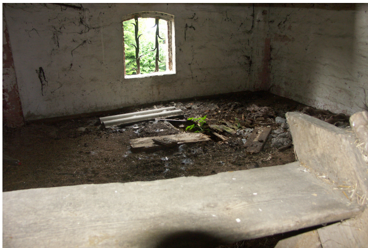
zdj. 25 Widok wnętrza poziomu górnego (II kondygnacja) przeszło 9 strona zachodnia z uwidocznionymi uszkodzeniami stropu
