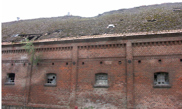
zdj. nr 2 Widok fragmentu (4 przeszła od 2-5) elewacji wschodniej budynku , z uwidocznionymi uszkodzeniami muru i dachu z uwidocznionymi uszkodzeniami konstrukcji więźby dachowej
