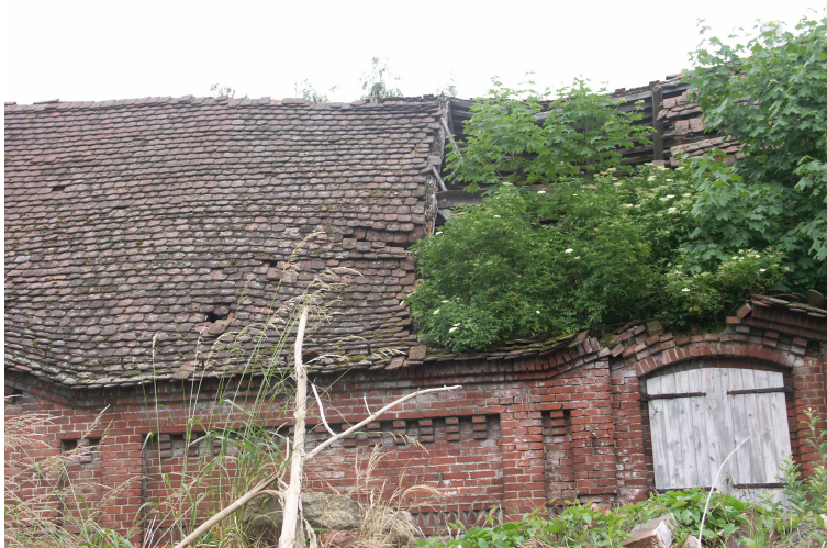
zdj. nr 8 Widok górnego fragmentu (2 przęsła 3-4) elewacji zachodniej budynku, uwidocznione zawalenie konstrukcji dachu, ubytki w gzymsach oraz nadprożu otworu, jak również erozja cegły z licznymi ubytkami spoiny
