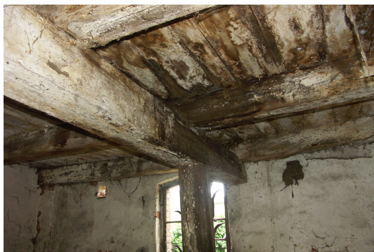
zdj. 27 Widok wnętrza poziomu dolnego (I kondygnacja) przeszło 9 strona wschodnia z uwidocznionymi uszkodzeniami stropu belek stropowych oraz belek wsporczych poprzecznych
