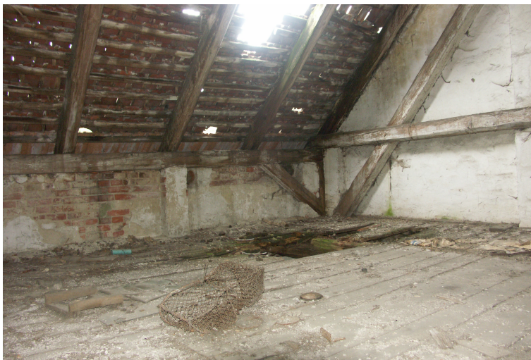
zdj. 23 Widok wnętrza poziomu górnego (II kondygnacja) przęsło 6 strona zachodnia z uwidocznionymi uszkodzeniami stropu oraz muru (pęknięcie, zawilgocenie oraz uszkodzenia cegieł)
